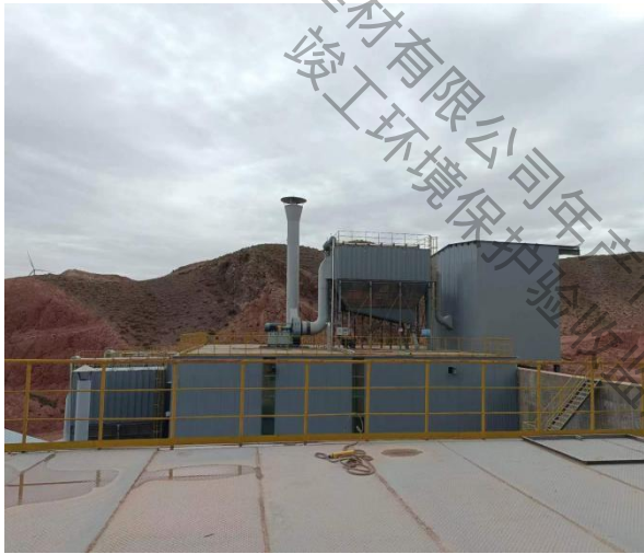
各工段布袋除尘器及排气筒
