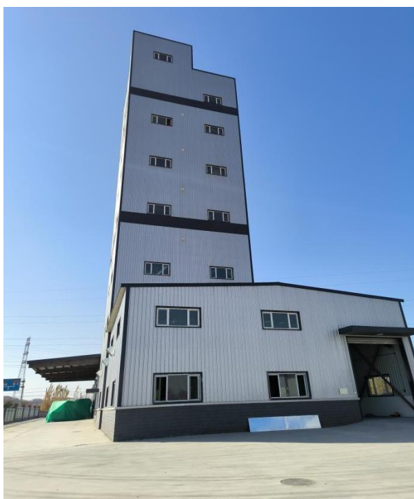
预混料生产车间
