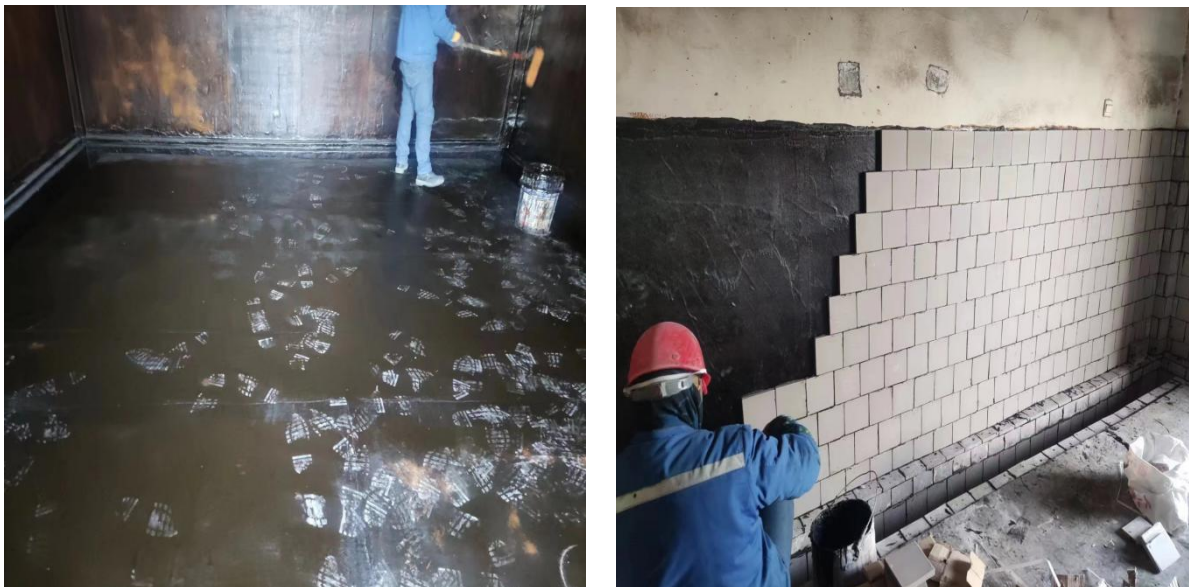
危险废物暂存间施工照片
