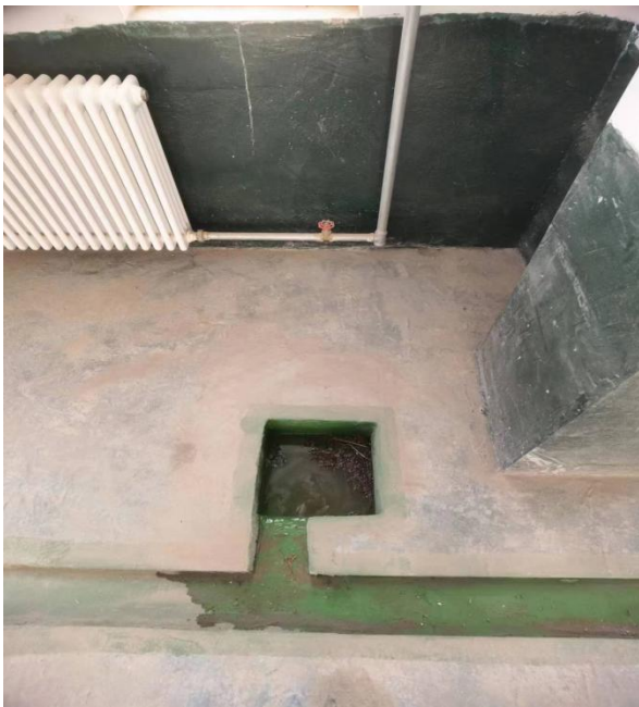
渗滤液收集池
